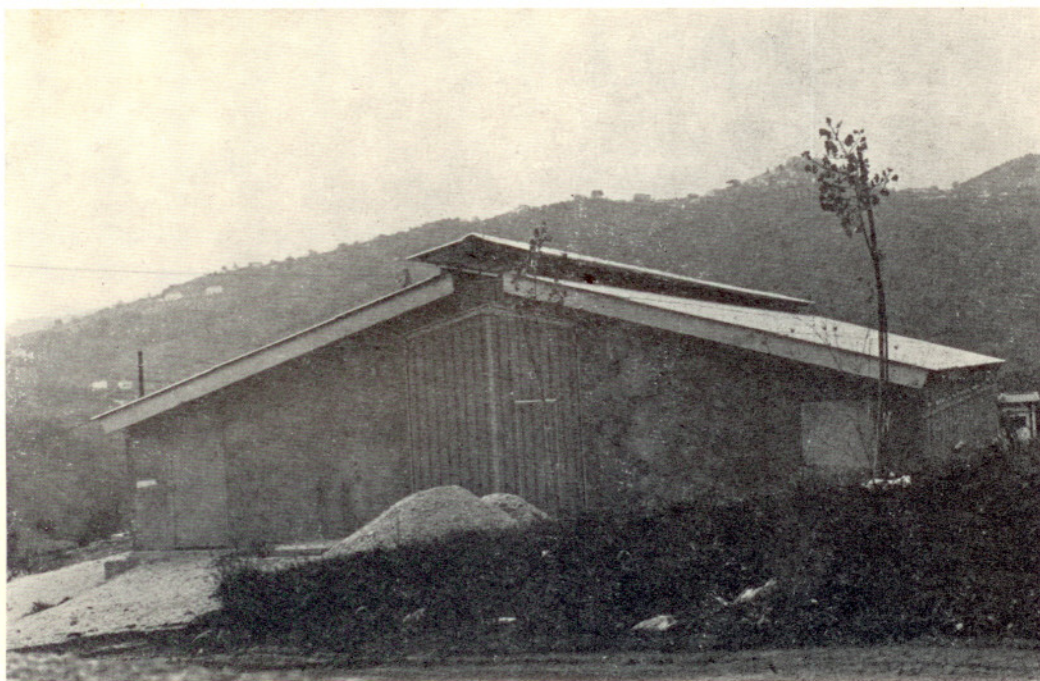
Stalla sociale in contrada Roccomanzi costruita dalla Provincia di Pisa e donata alla locale cooperativa zootecnica
